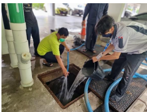
รูปที่ 9 การสูบน้ำเกรอะ บ่อดักไขมัน
