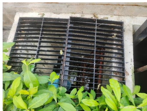
รูปที่ 14 ตะแกรงกรองเศษขยะรอบท่อระบายน้ำ
